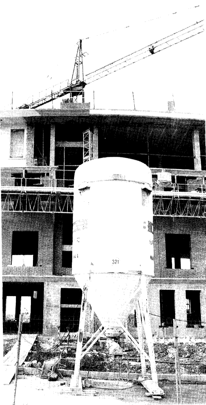
Construcción de una nueva promoción inmobiliaria en la CAV. Oskar
