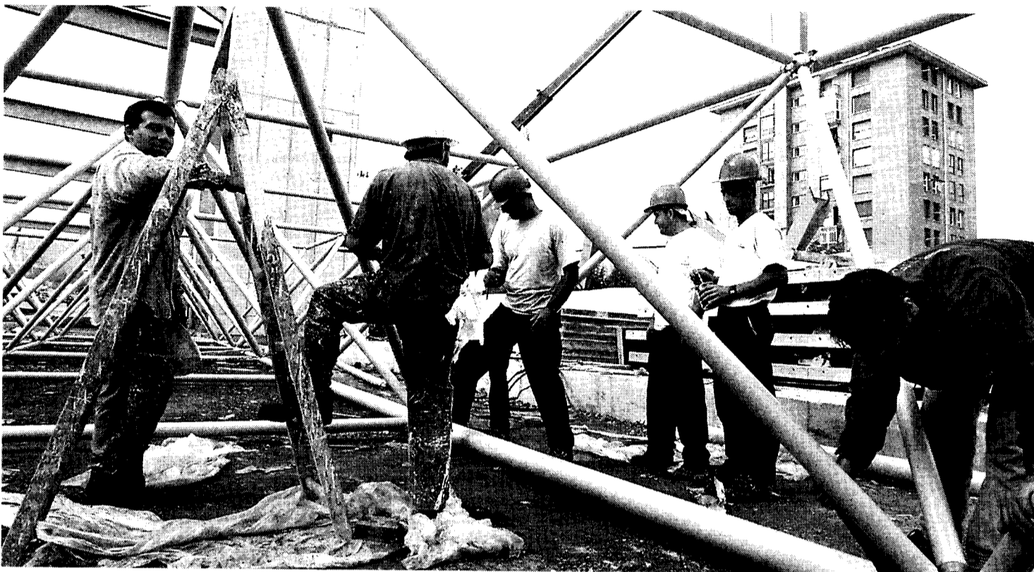
Empleados de la construcción trabajan en una promoción de vivienda en Ezkerraldea. Zigor Alkorta
