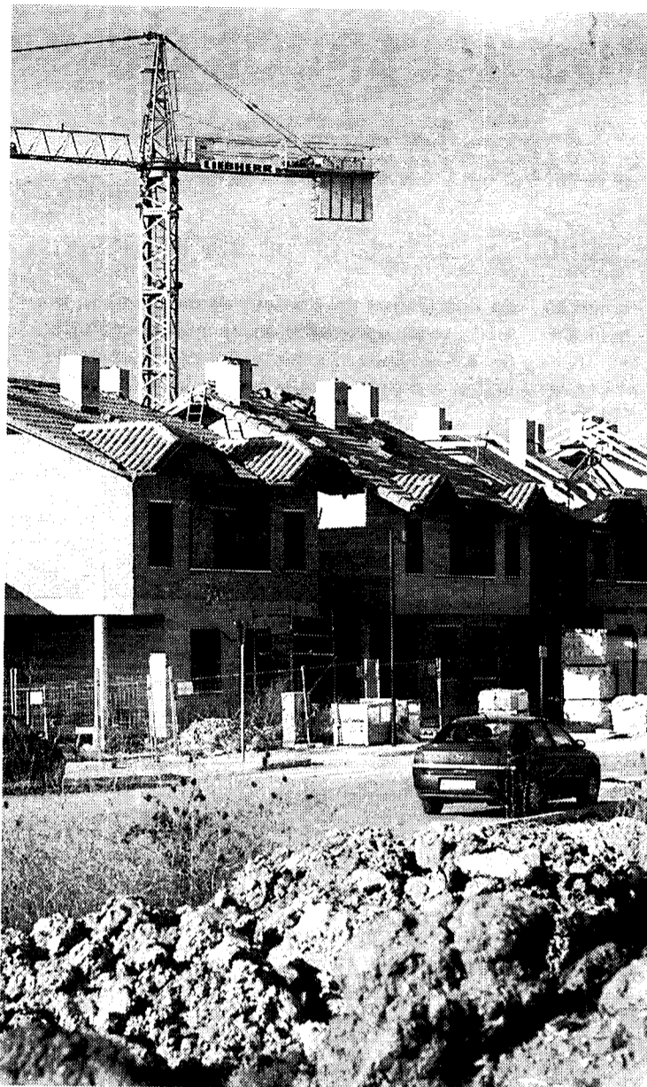
La construcción y demolición genera una gran cantidad de residuos.
