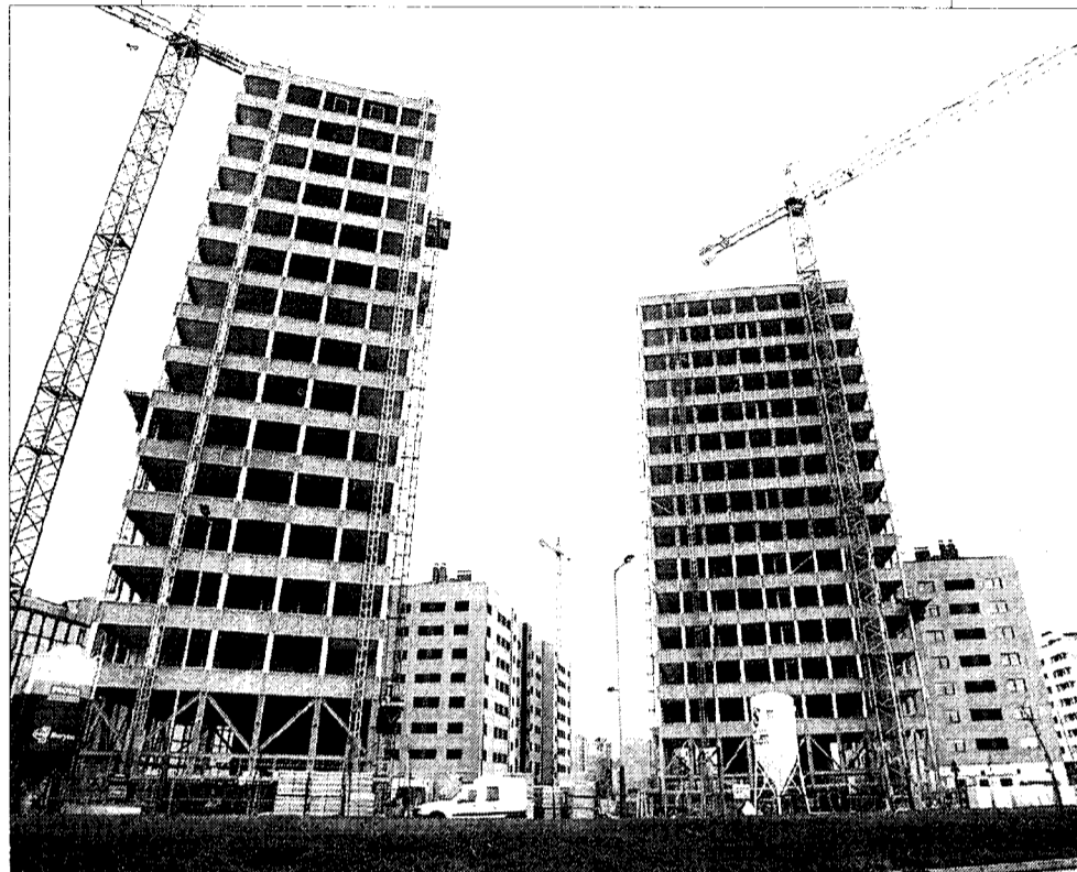
Edificios en construcción en el nuevo barrio de Salburua de Vitoria. / L. RICO
