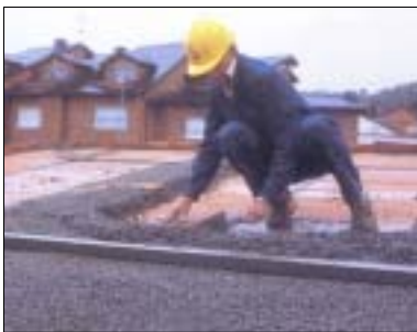
EXTENDIDO DE CAPA DE COMPRESIÓN
