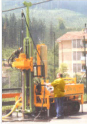
EQUIPO DE PERFORACIÓN
