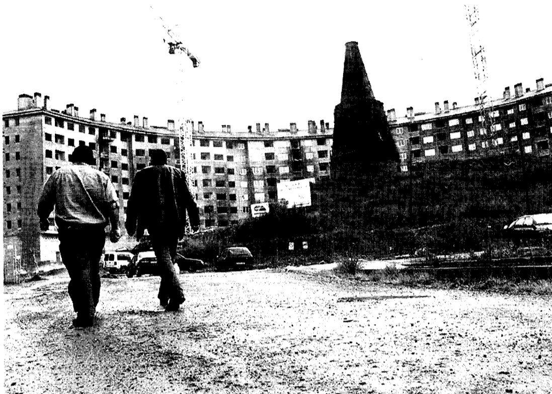
Ciudadanos pasean junto a unas viviendas en construcción. Ruiz de Azua
