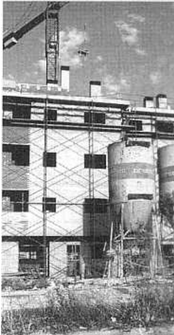
Viviendas en construcción. Archivo
