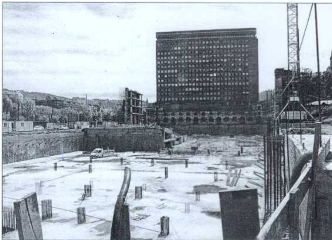
Un aspecto de las obras de Urribartarte donde se levantarán las dos grandes torres de Isozaki. / www
