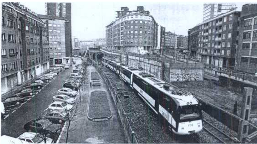
A CIELO ABIERTO. Ria 2000 quiere soterrar el tramo ferroviario de Feve entre Gordoniz y Basurto. / FERNANDO GÓMEZ
