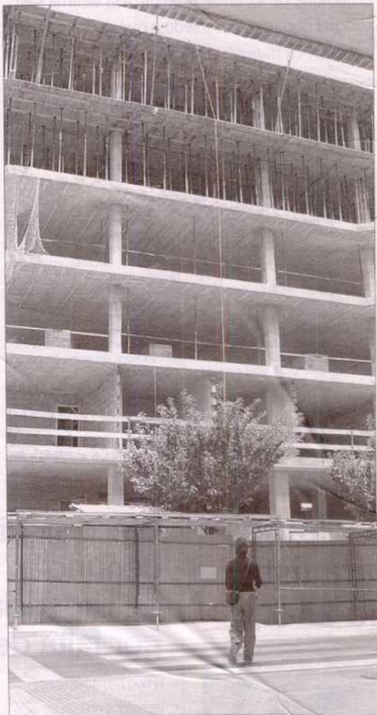
Los técnicos inspeccionarán 21 inmuebles en obras en Bizkaia.
