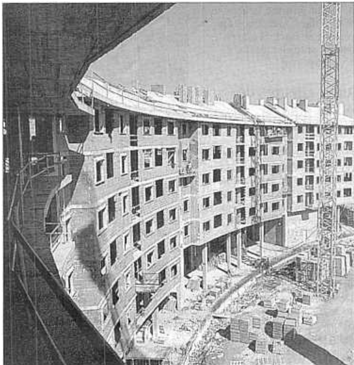
Construcción de viviendas en la zona de Miribilla. / IÑAKI ANDRES
