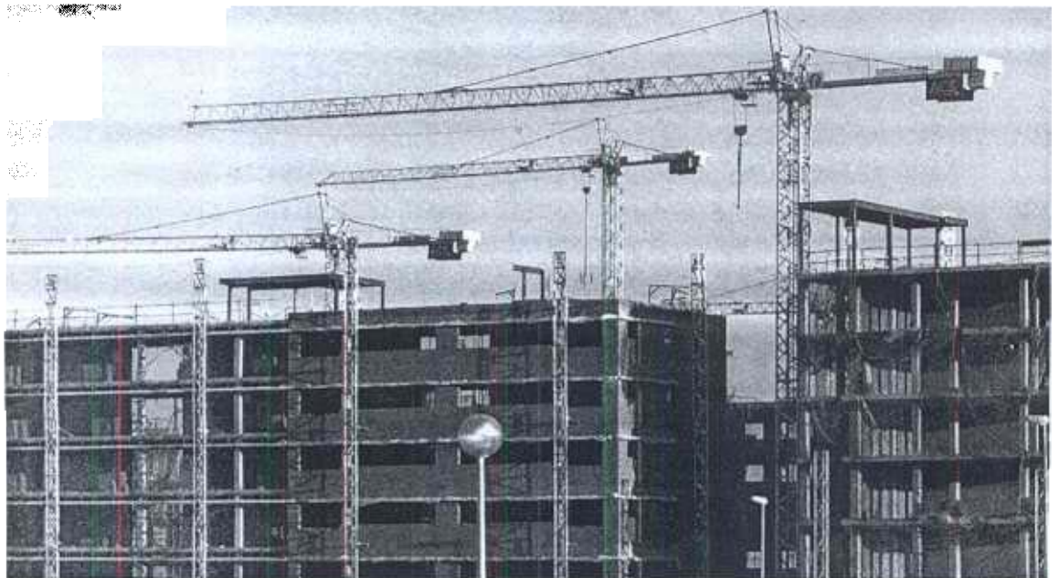
Grupo de grúas y edificios de viviendas en construcción. Efe
