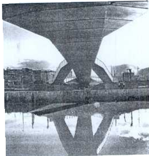
La pasarela peatonal Pedro Arrupe será el elemento esencial que conectará el nuevo Parque de Ribera con el barrio de Deusto y su Universidad.
