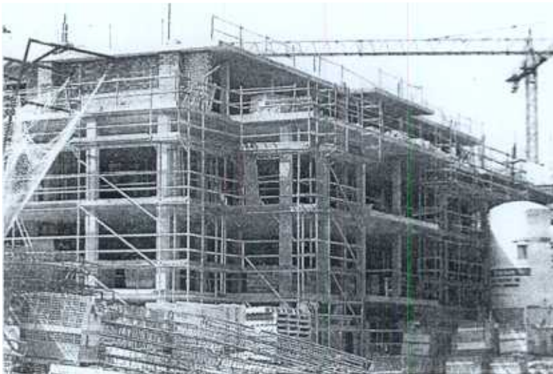
Construcción de un edificio de viviendas. DEIA
