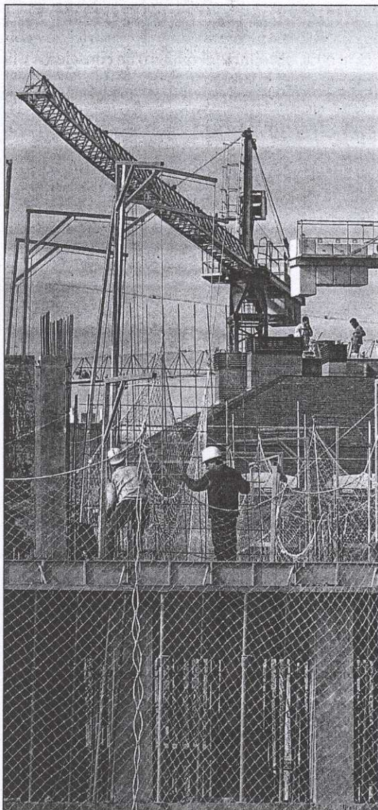
Unos operarios trabajan en la construcción de un edificio de viviendas. / MITXI
