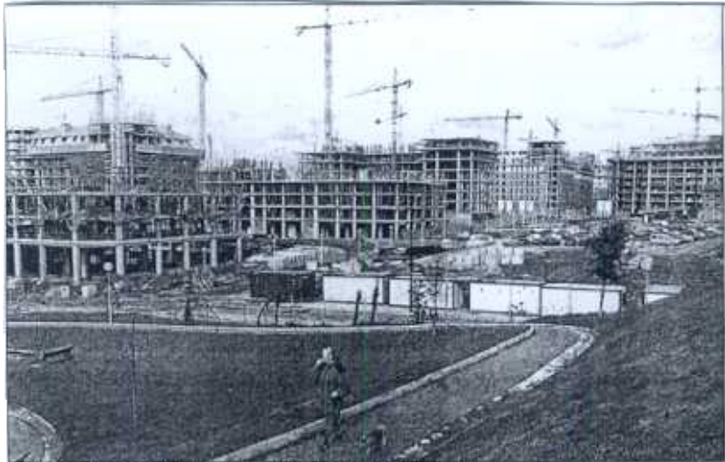
Bloques de viviendas en construcción en el parque bilbaíno de Mina Miribilla. J. IRIARZ
