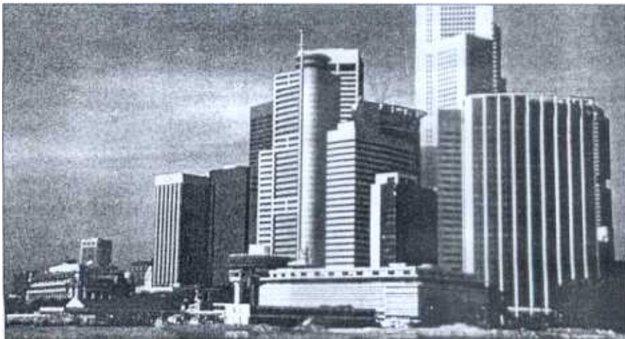
Las casas que habitamos y nuestros lugares de trabajo y ocio son fuente de contaminación, daño que se puede reducir.
