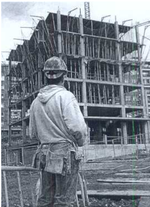
Un operario trabaja en las obras de un edificio de Bilbao. / MITXEL ATRIO
