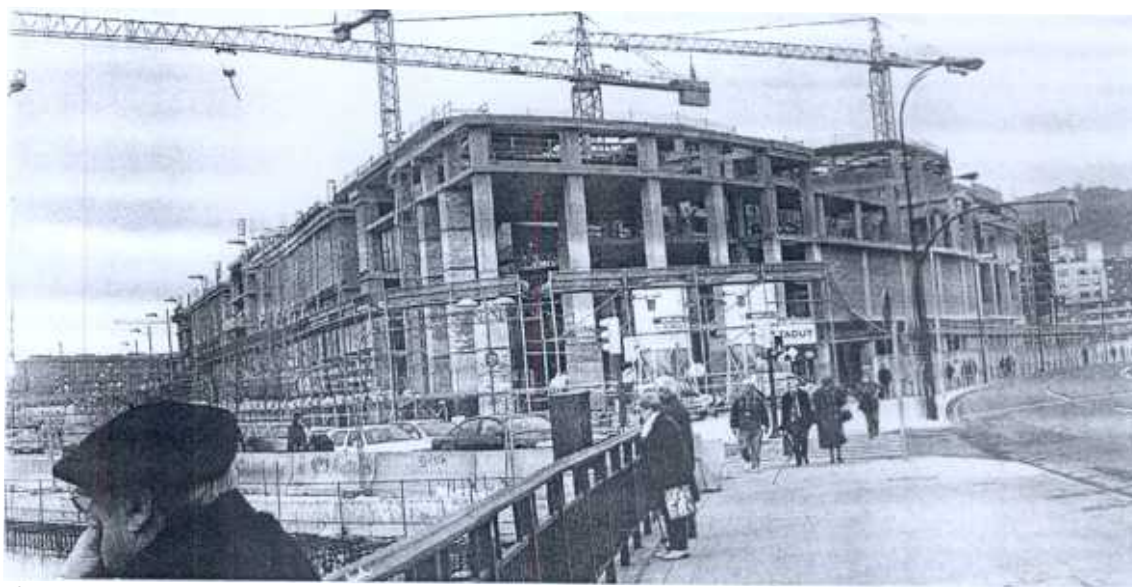
juipuzcoano Luis Peña Ganchegui, junto a las obras del centro comercial . / IGNACIO PÉREZ
