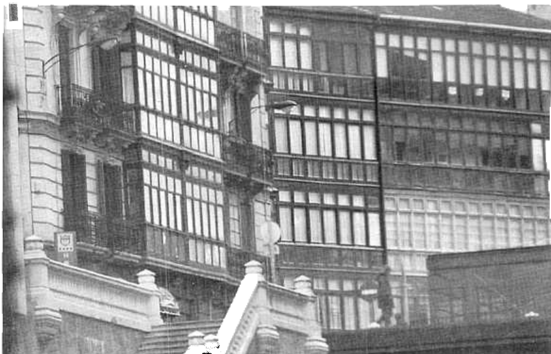
Vista parcial de varios inmuebles de la capital vizcaina. Zarrabeitia
