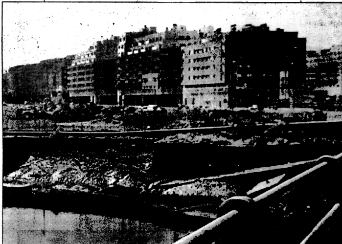
Viviendas en construcción en Barakaldo. / TXETXU BERRUEJO
