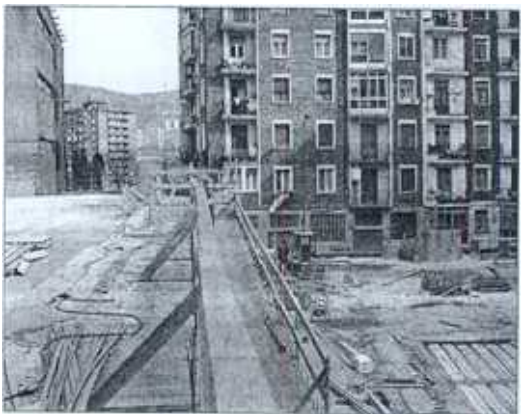
Estado actual de los trabajos en la plaza Kirikiño
