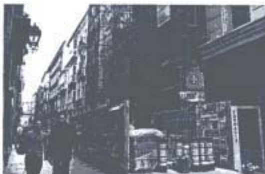
El arreglo de fachadas es la obra de reforma más frecuente.
