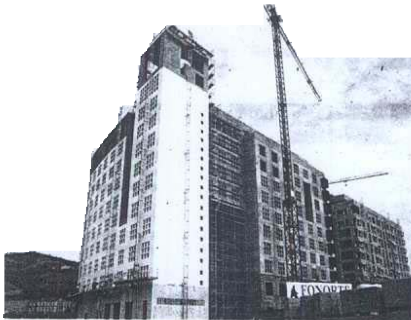
Junto al hotel Sheraton, actualmente en plena construcción, se levantarán cinco bloques con un total de 800 pisos.
