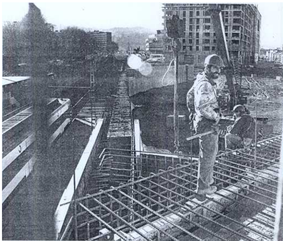
Dos empleados trabajan en las obras de Zubiarte, al lado del Puente del Deusto, donde se observan terminados la cimentación y el aparcamiento. Ángel Ruiz de Azua
