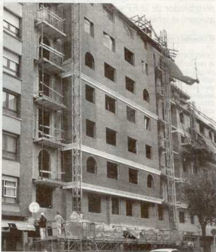
En la imagen, la fachada de un edificio en construcción Archivo
