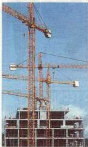
Unas viviendas en construcción.
