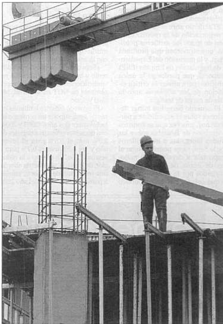
Un obrero trabaja en un bloque de viviendas en construcción. / MITXI
