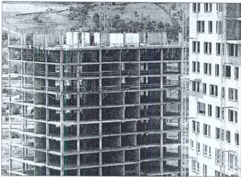
Construcción de viviendas de protección oficial en Barakaldo. / SANTOS OJILLO
