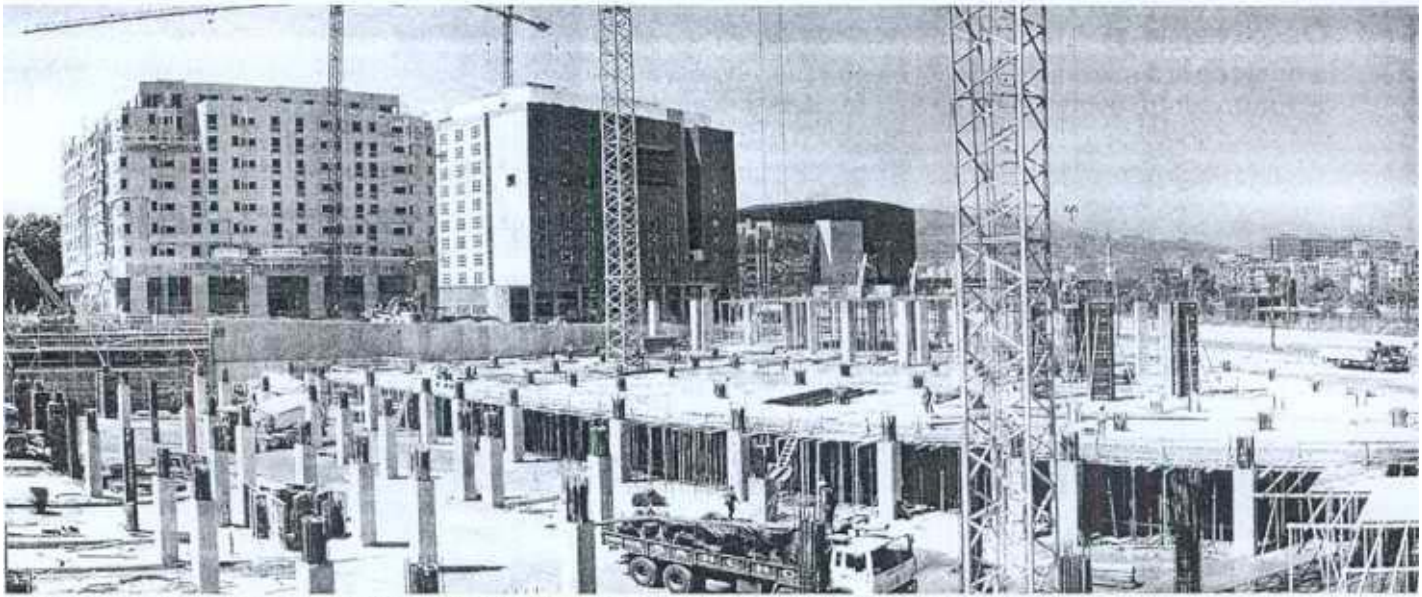
EN MARCHA. Las obras del centro comercial Zubiarte se acometen en los niveles de planta y de primer piso del parking. / IGNACIO PÉREZ
