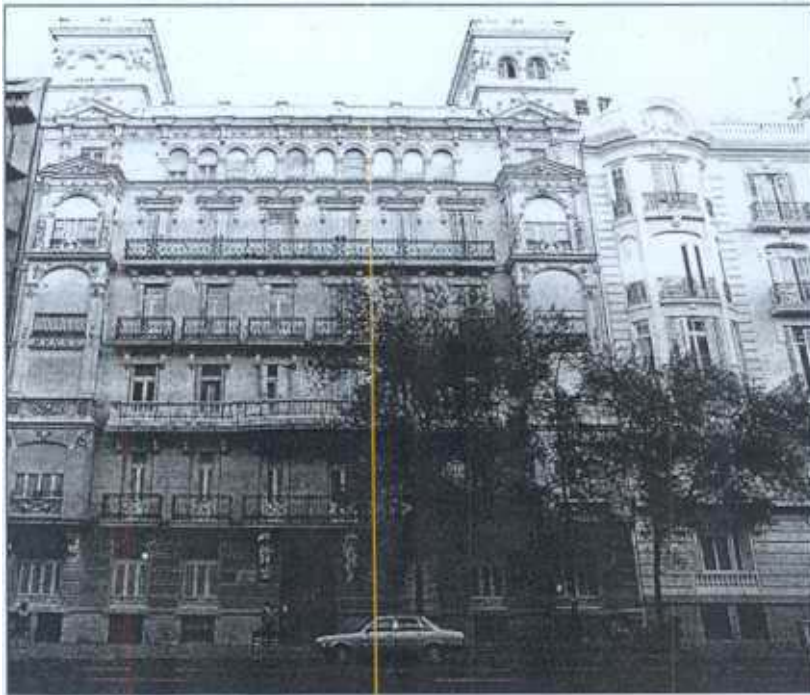
El Departamento de Vivienda del Gobierno vasco prevé que se revisen de forma prioritaria los edificios construidos antes de 1930.
