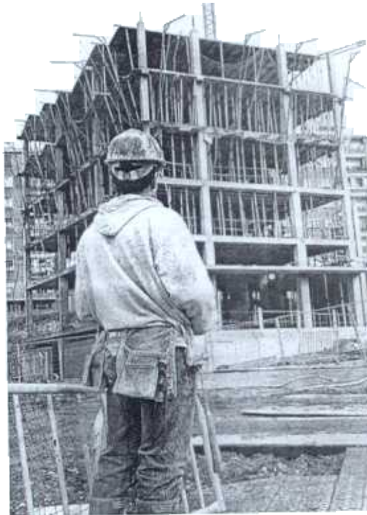
Viviendas en construcción en un barrio de Bilbao. / MITXEL ATRIO
