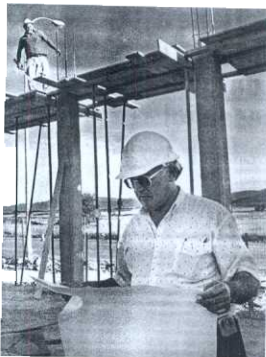
MANOS A LA OBRA. Edificio en construcción en Vitoria. / B. CASTILLO
