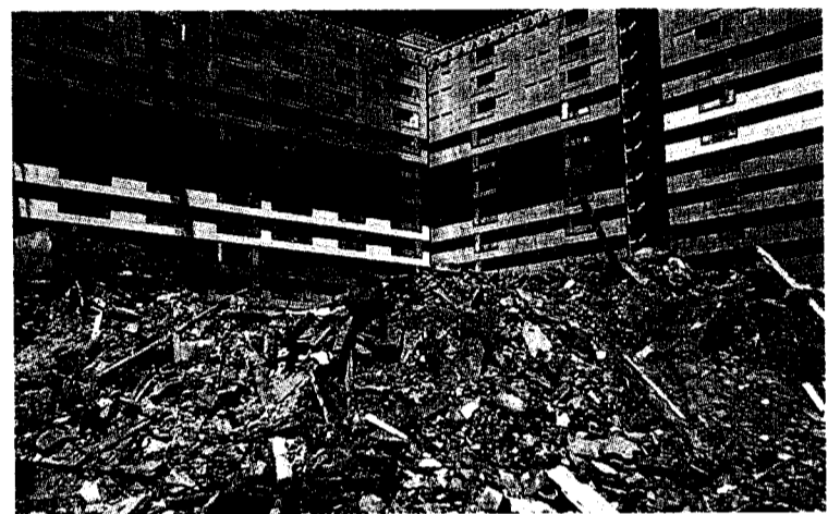
Toda actividad relacionada con la construcción genera abundantes residuos. ▶ i. m.
