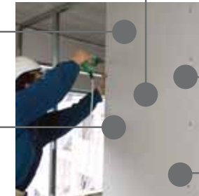
tabique de pladur (placas de yeso laminado y estructura interior metálica)
